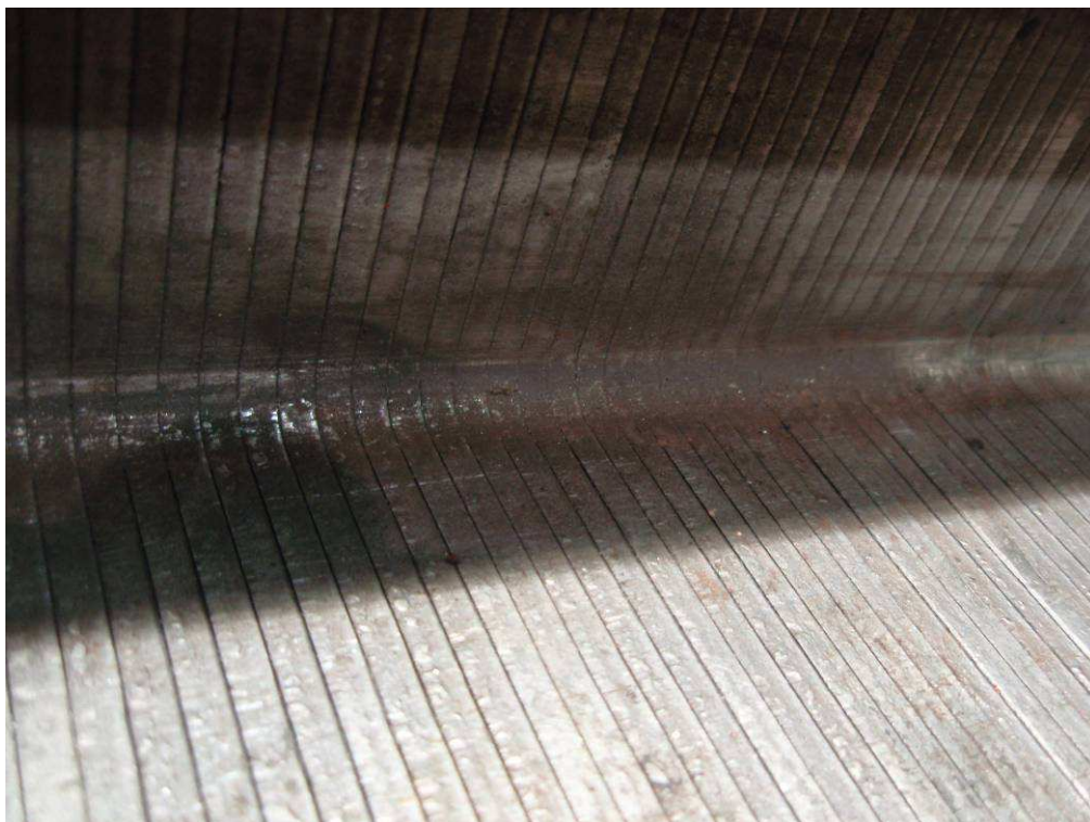
Bild 1: gereinigter Prüfbereich, zum prüfen geeignet
