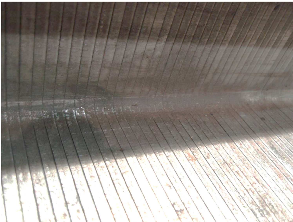
Bild 1: gereinigter Prüfbereich, zum Prüfen geeignet
