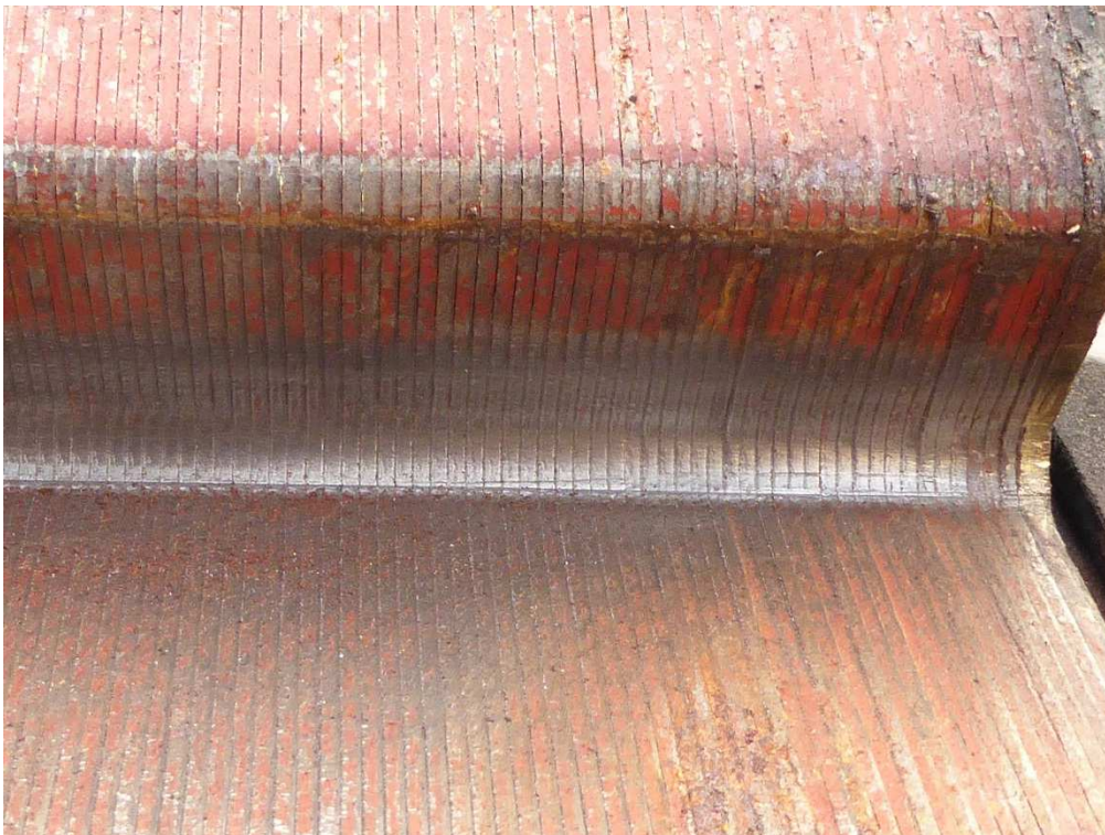
Bild 3: gereinigter Prüfbereich, zum Prüfen geeignet.
